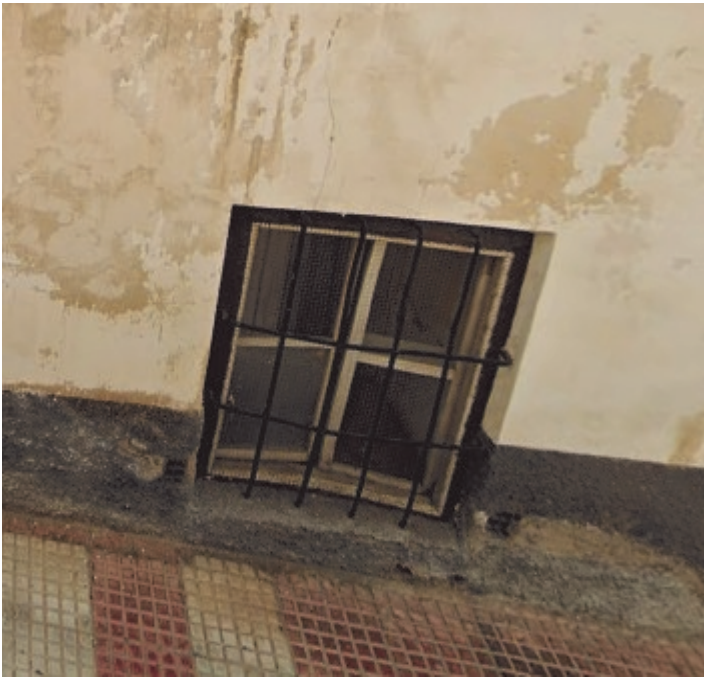
Otra ventana a ras de suelo para ventilar una habitación que se encuentra bajo el nivel de la acera. ¿dónde está?
