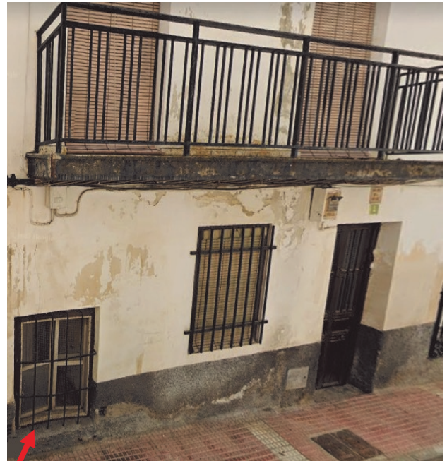
Esta ventana a nivel de la acera se encuentra en el nº 4 de la calle Juan Carlos I, y servía para dar luz y ventilación a una habitación que estaba muy baja en la casa.
